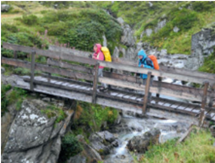
Brücke über die Rosanna
